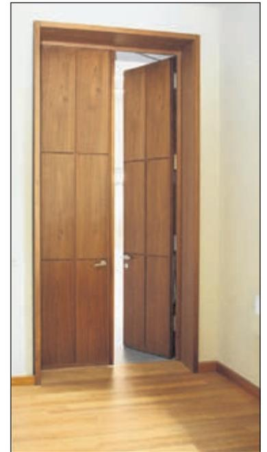
geht es aber auch darum, das Einströmen von Rauchgasen zu verhindern. So müssen sogenannte Rauchschutztüren über spezielle Dichtungen verfügen.
